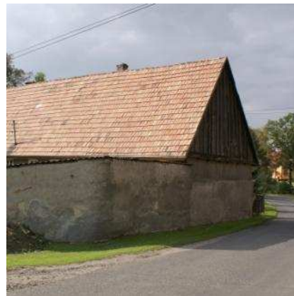
mur łączony (mur otynkowany + drewno)
