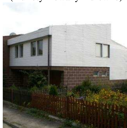
siding z paneli z tworzyw sztucznych
