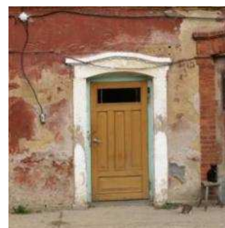
charakterystyczne obramienia drzwi
