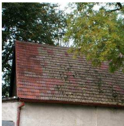
dachówka cementowa
