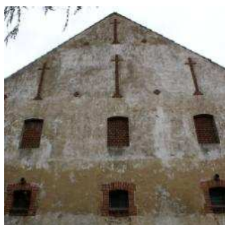
typowy układ ścian szczytowych w budynkach gospodarczych – symetryczny z powtarzającym się motywem krzyża (otwory wentylacyjne)
