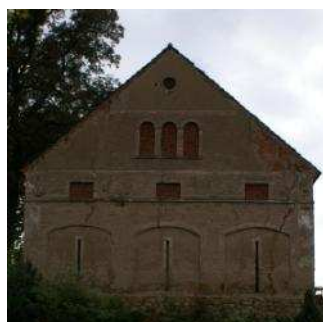
typowy układ ścian szczytowych w budynkach gospodarczych – symetryczny z powtarzającym się motywem krzyża (otwory wentylacyjne)
