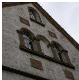
ściana szczytowa z typowym trójdzielnym układem okien
