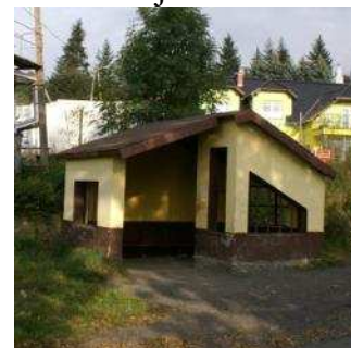
zaniedbany przystanek PKS
