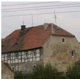
dach naczółkowy + mur pruski
