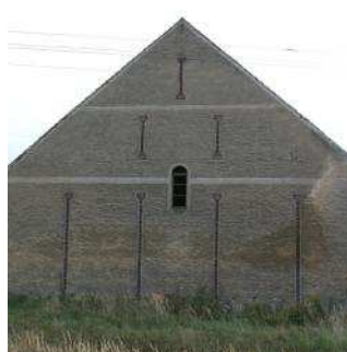
typowy układ ścian szczytowych w budynkach gospodarczych – symetryczny z powtarzającym się motywem krzyża (otwory wentylacyjne)
