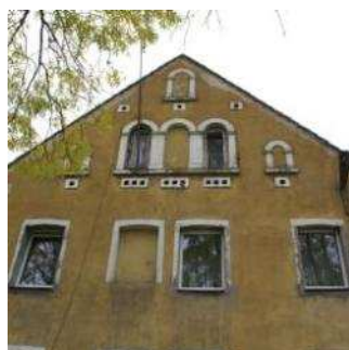
ściana szczytowa z typowym trójdzielnym układem okien
