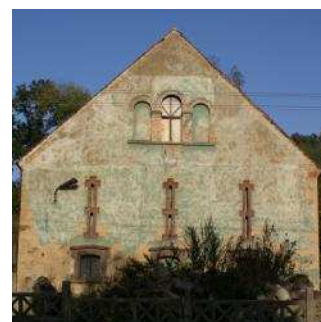
typowy układ ścian szczytowych w budynkach gospodarczych – symetryczny z powtarzającym się motywem krzyża (otwory wentylacyjne)
