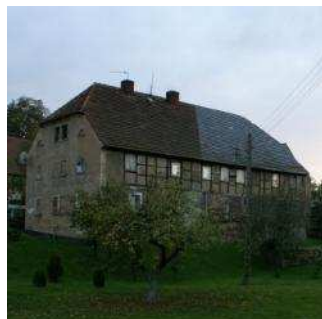
dach naczółkowy + mur pruski
